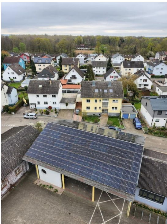
PV-Anlage auf der Festhalle Neuburgweier
